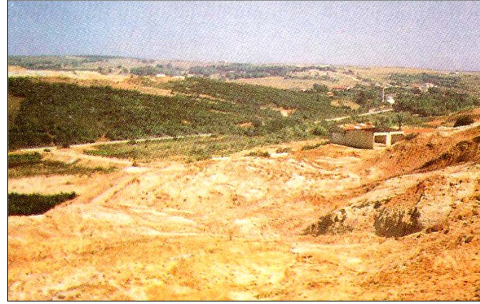
ARAZİNİN DÜZELTİLMİŞ VE RİPER İLE İŞLENMİŞ DURUMU
