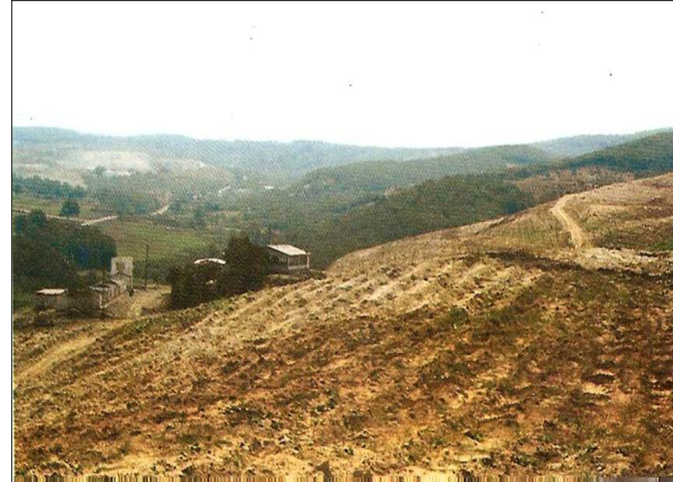
ARAZİNİN DÜZELTİLMİŞ VE RİPER İLE İŞLENMİŞ DURUMU
