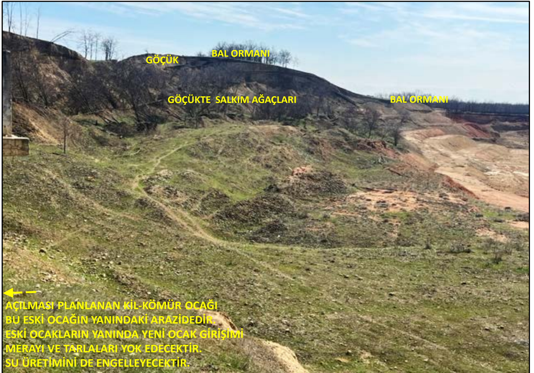
RESİM 3. POYRALI'DA AÇIK MALZEME OCAĞININ YARMASI GÖÇMÜŞ, KÖYLÜNÜN BAL ORMANI AĞAÇLANDIRMASINI DA GÖÇERTMİŞ
