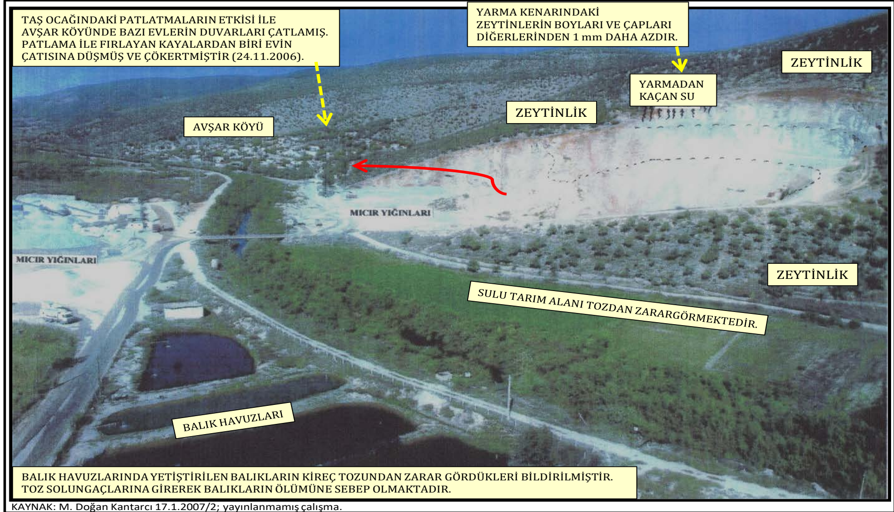
RESİM 9. AVŞAR VE YAŞYER (MİLAS) KÖYLERİ ARASINDAKİ TAŞ OCAĞI İLE KIRMATAŞ TESİSİNİN VE MICIR YIĞINLARININ ZEYTİNLİKLER, TARIM ALANLARI, TARLA BALIKÇILIĞI, KÖY YERLEŞİMİ ÜZERİNE VE YAMAÇ SIZINTI SUYU KAYBINA ETKİLERİ
