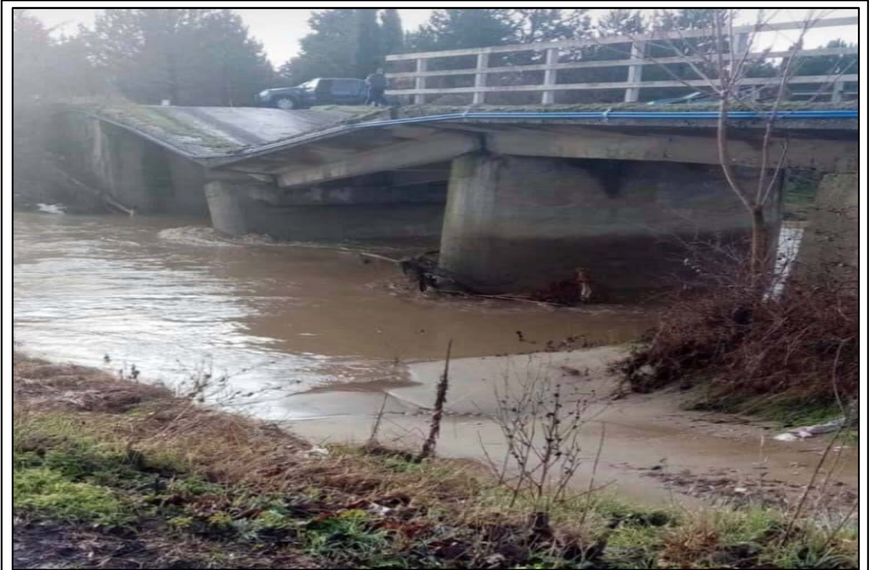
RESİM 1. TURGUTBEY KÖYÜ KARAAĞAÇ DERE (Mezarlık yanı) KÖPRÜSÜ 2.2.2021
